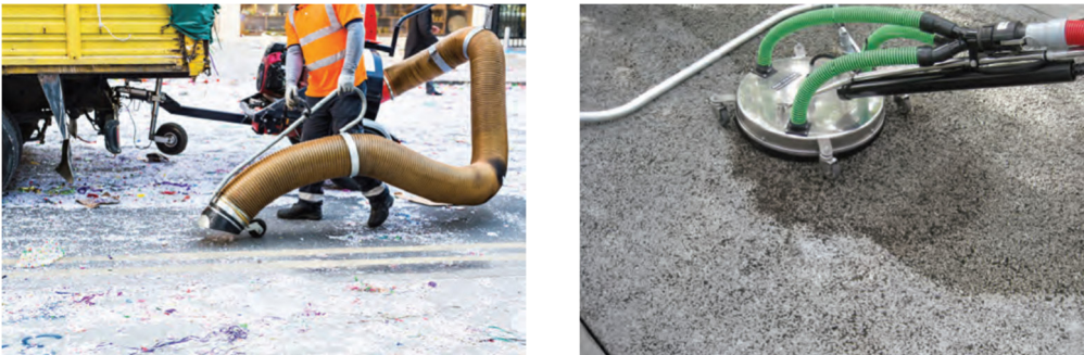
Şekil 13. Geçirimli beton vakumla temizleme işlemi
