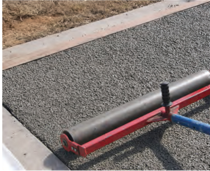
Şekil 4. Geçirimli betonun sıkıştırılması
