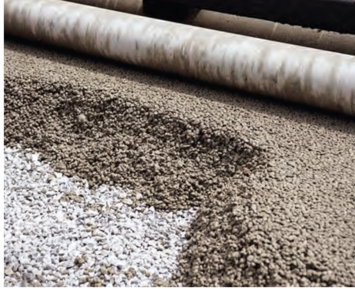
Şekil 12. Geçirimli betonun silindir ile sıkıştırma işlemi
