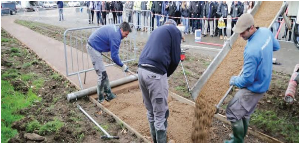
Şekil 11. Geçirimli beton döküm işlemi[9]
