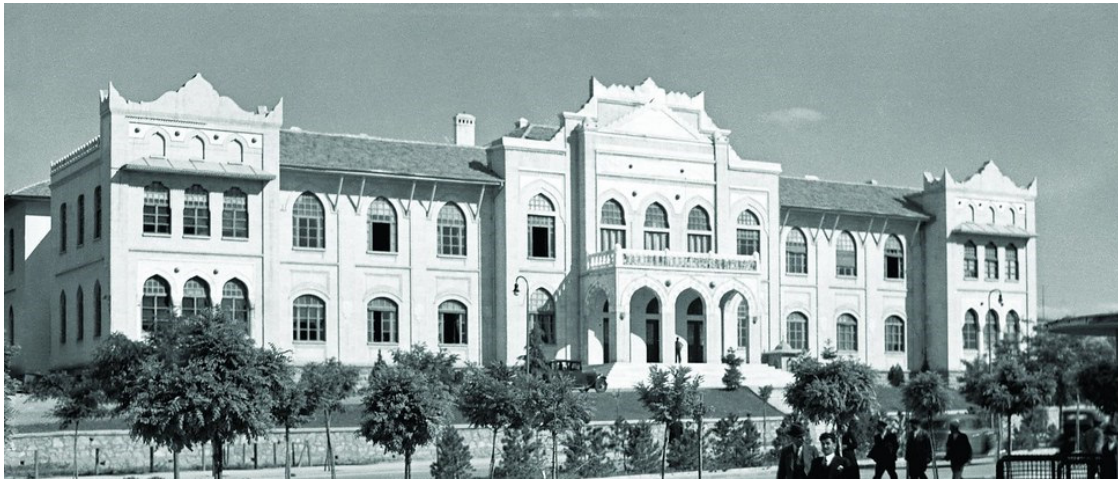
Figure 8. Hariciye Vekaleti Binası cephesi
